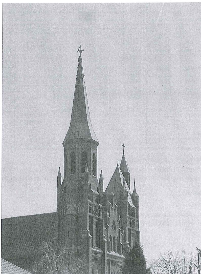
Zdjęcie 1 Badany obiekt
