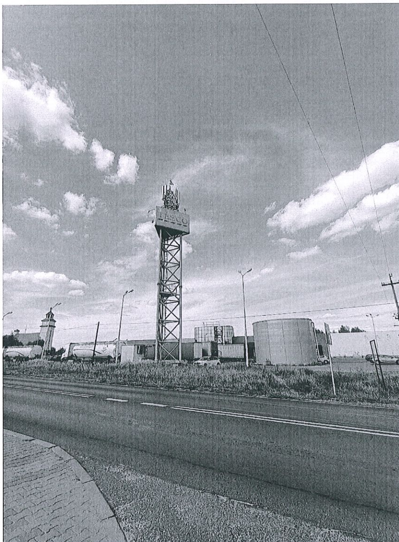
Zdjęcie 1 Badany obiekt
