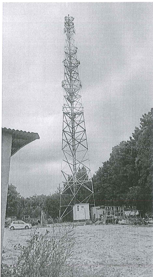
Zdjęcie 1 Badany obiekt
